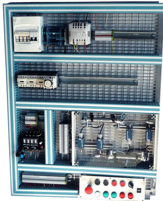
Exemple de platine montée et câblée
